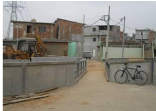
URBANIZAÇÃO EM ANDAMENTO:
