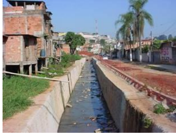
URBANIZAÇÃO EM ANDAMENTO:
