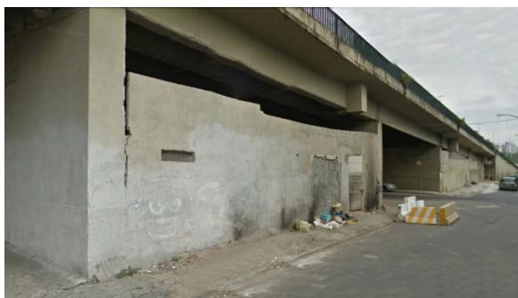
VIADUTO ORLANDO MURGEL
