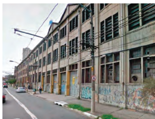
Rua dos Trilhos - patrimônio industrial
