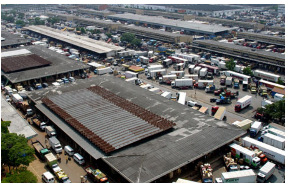
Imagem que mostra o grande tráfego de caminhões fonte: Google
