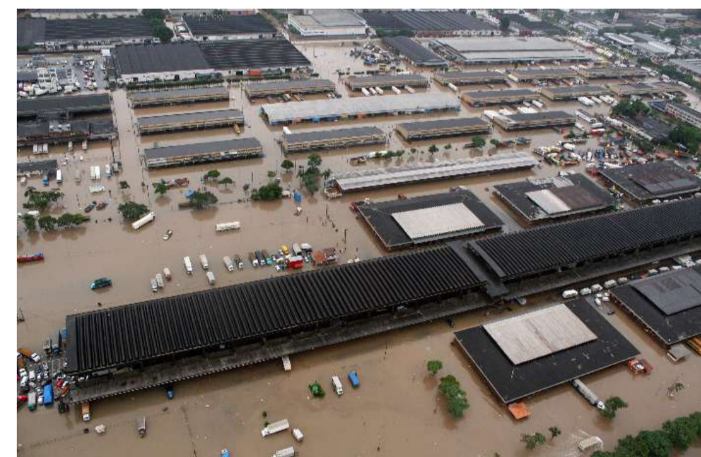
Imagem mostra o problema de drenagem do local fonte: Google
