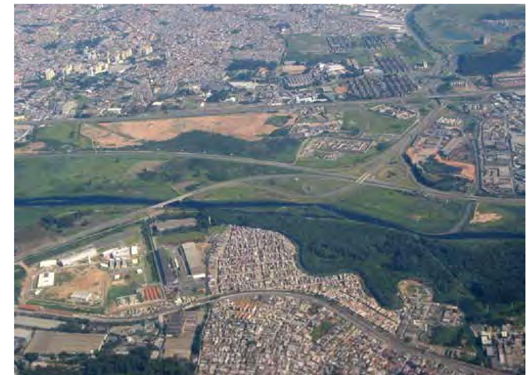
Fig. 13. Vista aérea da área, destaque para os eixos rodoviários, a área do parque e a região da Fábrica
