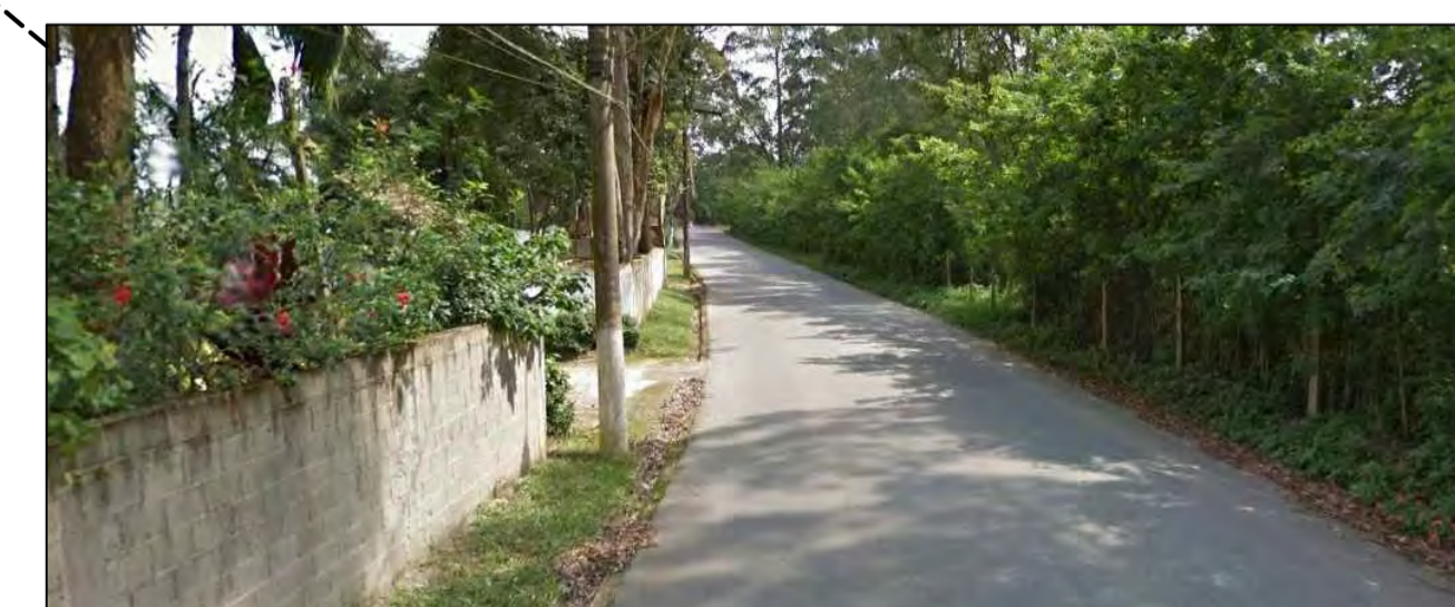
Ruas com poucas infra-estruturas e sem calçadas.
