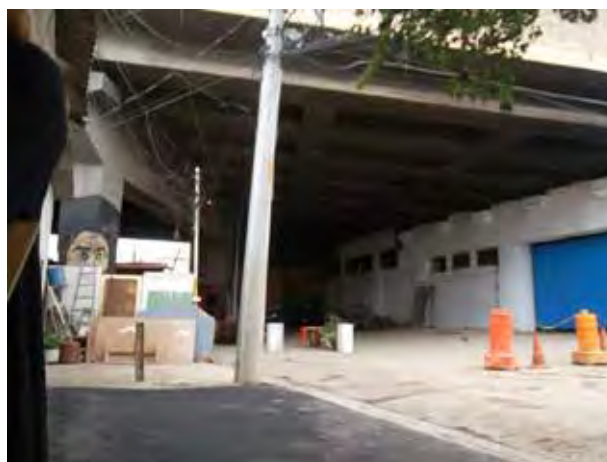
Área 5 e acesso a entrada da favela do Moinho.
