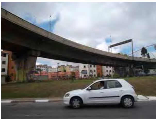
Viaduto Bom Pastor, área 5. Partes coberta e descoberta.
