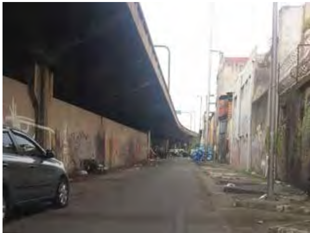
Área 2, equipamento da SMADS; rua sem saída. Vista a partir da R. do Glicério.
