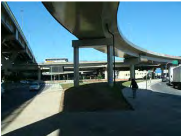
Nova alça de acesso da Av. Jacu Pêssego para a Av. José Pinheiro Borges. Vista a partir da Av. Pires do Rio.
