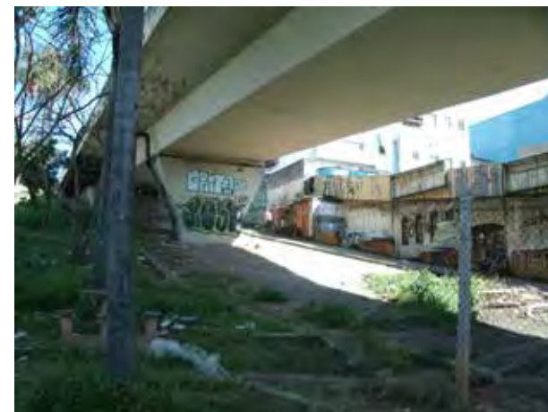
Baixo do viaduto Ladeira do Xisto.
