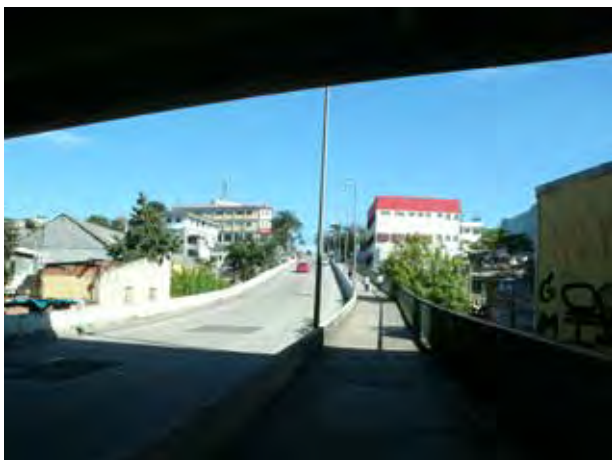
Viaduto Ladeira do Xisto sob viaduto Jacu Pêssego.
