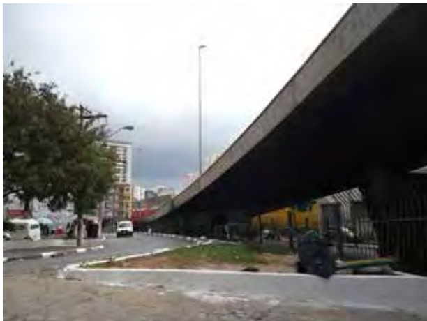
Viaduto Alm. Delamare, situação atual da área 3.
