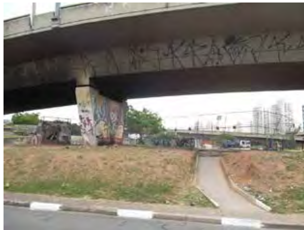
Viaduto Bom Pastor, área 5.
