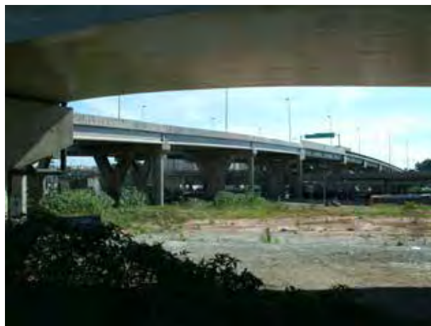
Alça de acesso do viaduto José Pinheiro Borges ao viaduto Jacu Pêssego. Vista a partir da R. Geraldo Vieira de Castro.
