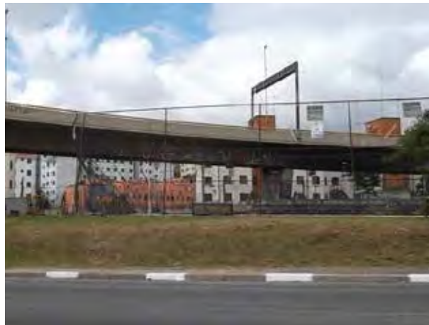
Quadras gradeadas na área 5 do viaduto Bom Pastor.
