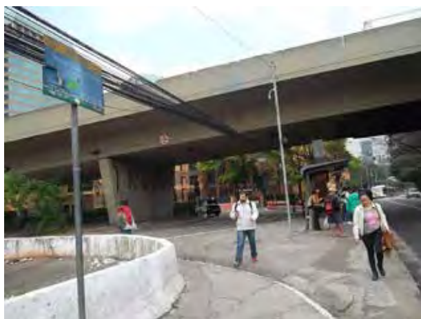
Ponto de ônibus na Av. das Nações Unidas, área 2.
