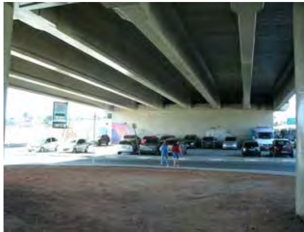
Baixo do viaduto José Pinheiro Borges, área utilizada como estacionamento à R. Geraldo Vieira de Castro.
