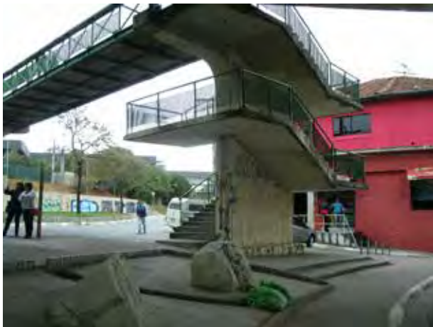
Passarela sobre a Av. Águia de Haia, com acesso próximo aos áreas 1 e 2.
