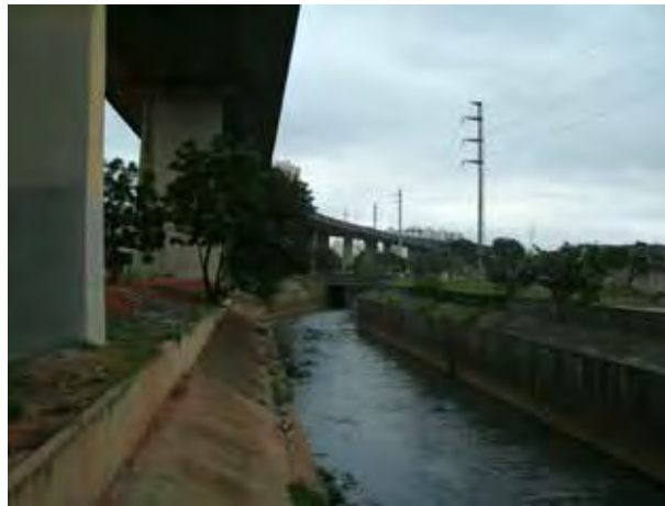
Vista do viaduto e Rio Aricanduva, a partir da Av. Aricanduva.
