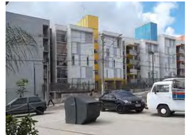
Área 2, utilizada como estacionamento. Também abriga um sistema de coleta de lixo mecanizada.
