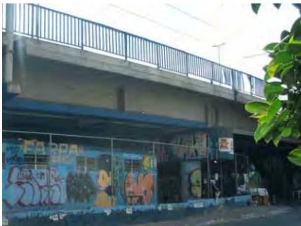
Av. Alcântara Machado, área 1, equipamento público.
