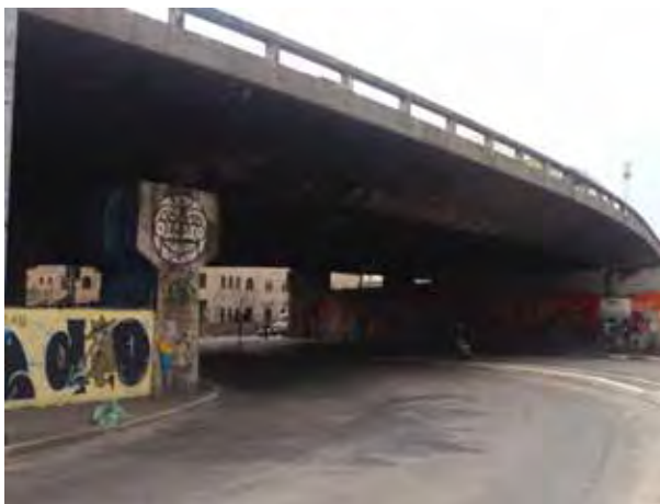
Baixo do viaduto entre as áreas 3, à esquerda, e 4, à direita.
