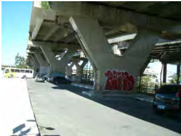
Baixo do viaduto Jacu Pêssego, visto a partir da R. Lagoa Salgada.
