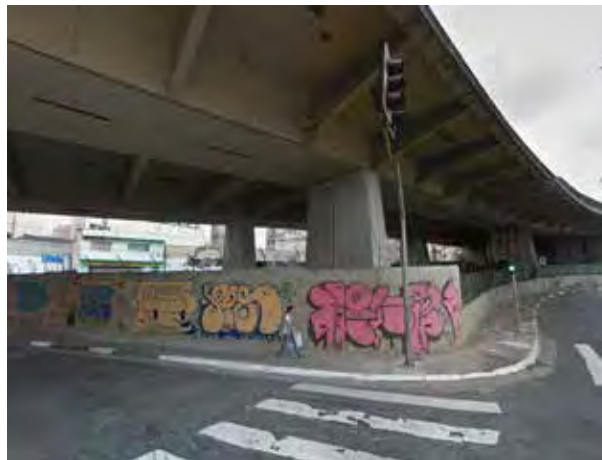
Área 2, utilizada como estacionamento na R. Jaceguai, esquina com a R. da Abolição.
