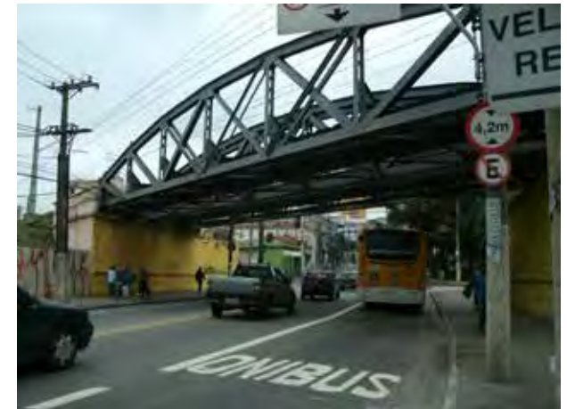
Transposição da linha férrea sobre R. Manoel Graça.
