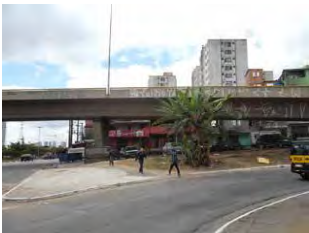
Área 4 do viaduto Alm. Delamare utilizada como estacionamento.
