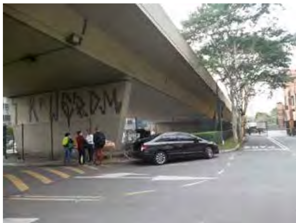
Vista para a área 2, a partir da Av. das Nações Unidas, área fechada.
