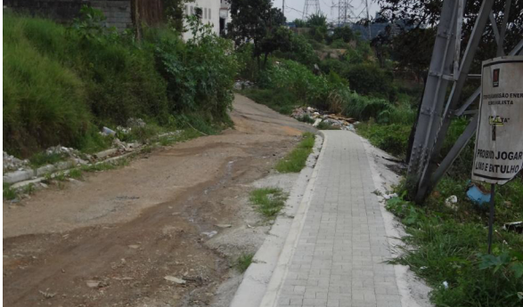
1. Construção de passeio e viela. Capela do Socorro
