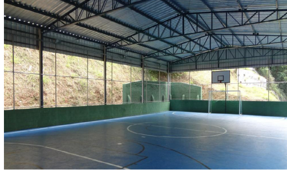
2. Cobertura de quadra. M'Boi Mirim
