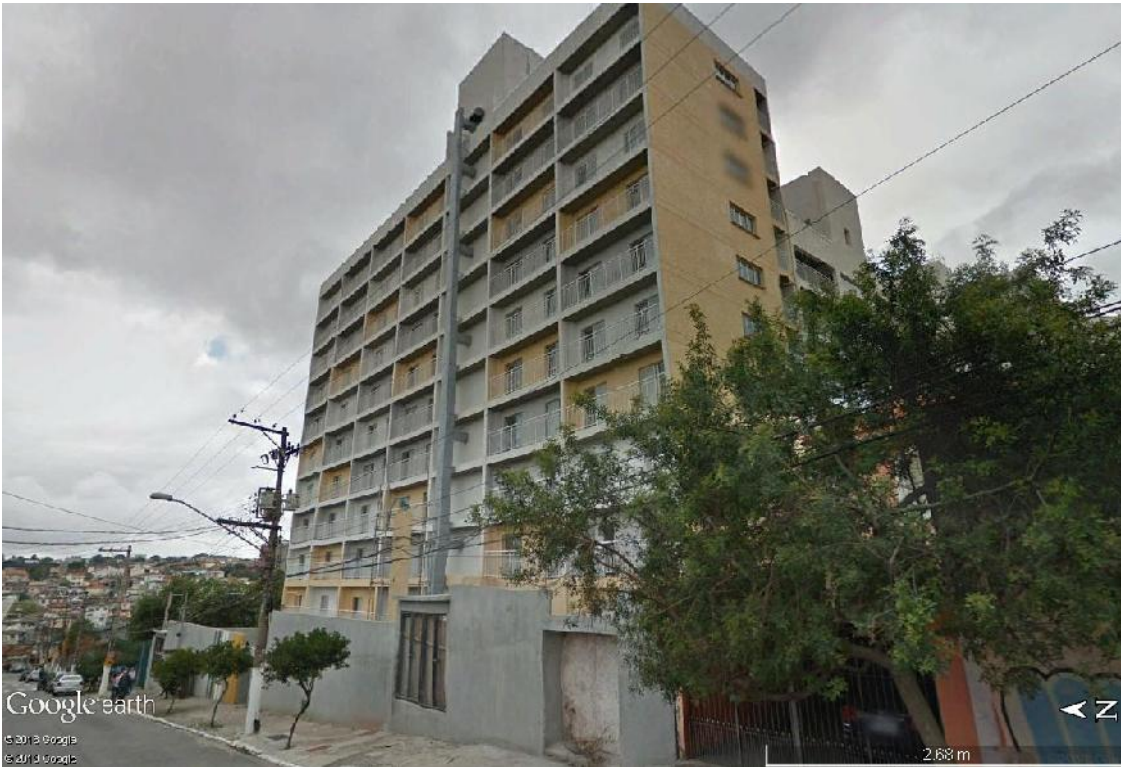
Fachada Rua Coriolano Durand
