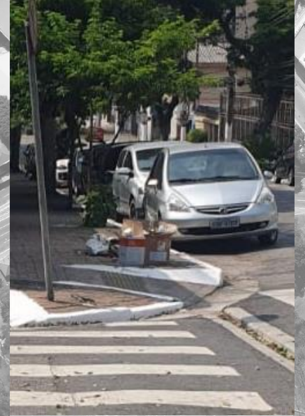
Descarte irregular de resíduos
