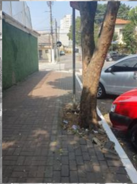
Calçadas danificadas e com acúmulo de lixo nos canteiros das árvores
