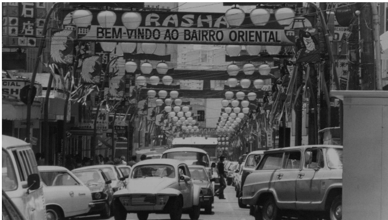
Entrada do bairro da Liberdade na década de 80 – as luminárias foram instaladas na década de 1970. Fonte: Gazeta de SP.
