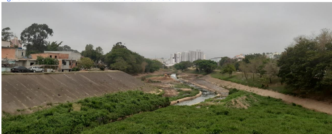
Figura 16: Reservatório de Amortecimento Ribeirão Oratório.
