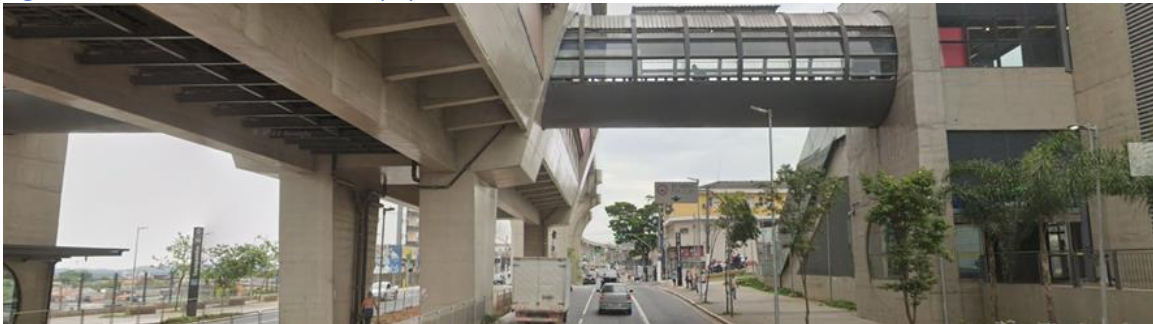
Figura 23: Faixa Exclusiva da Av. Sapopemba sentido Bairro.
