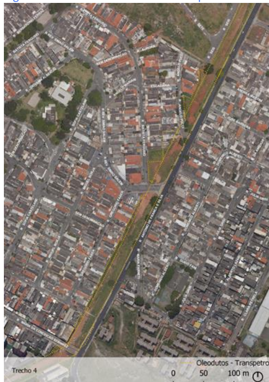
Figura 11: Trecho 4 do Duto da Transpetro.
