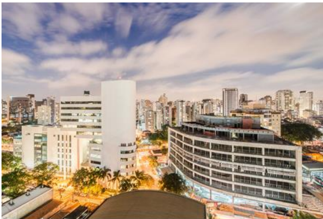
Figura 04 – Edifícios do Instituto de Ensino e Pesquisa Insper
