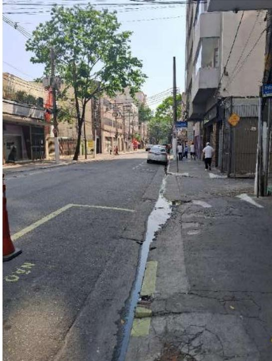
Figura 171 - Rua Anita Garibaldi, exemplo de passeio com piso irregular, sem piso tátil e rampas de acessibilidade em mal estado
