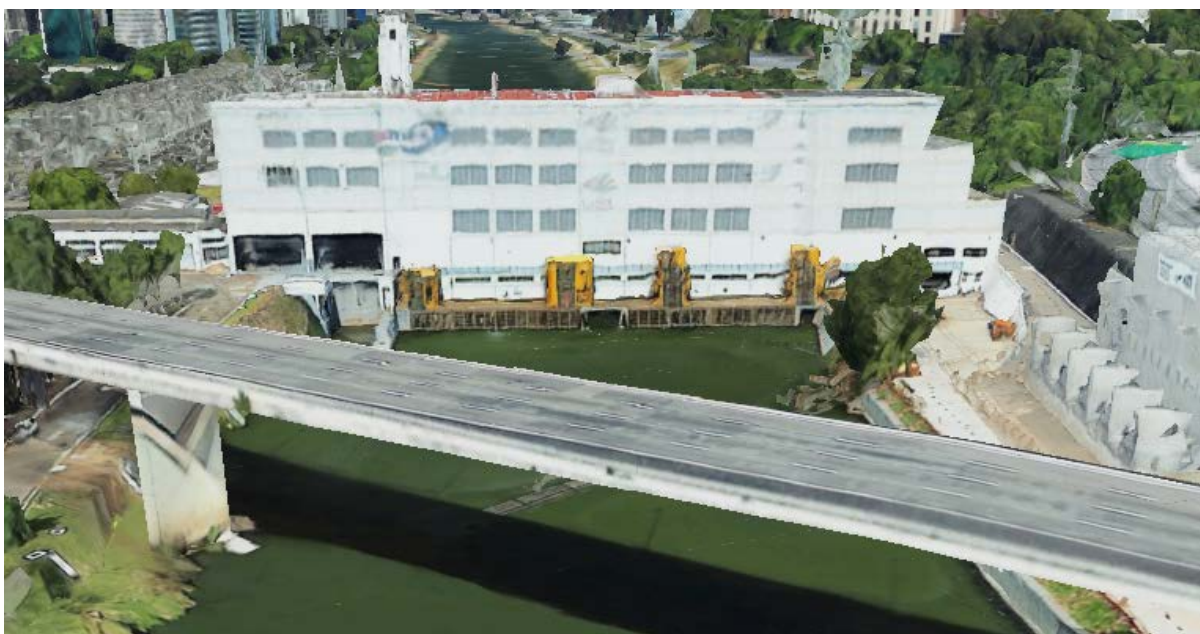
Ilustração 3 – Vista do pilar da Ponte Engenheiro Ary Torres sobre o Canal Inferior
