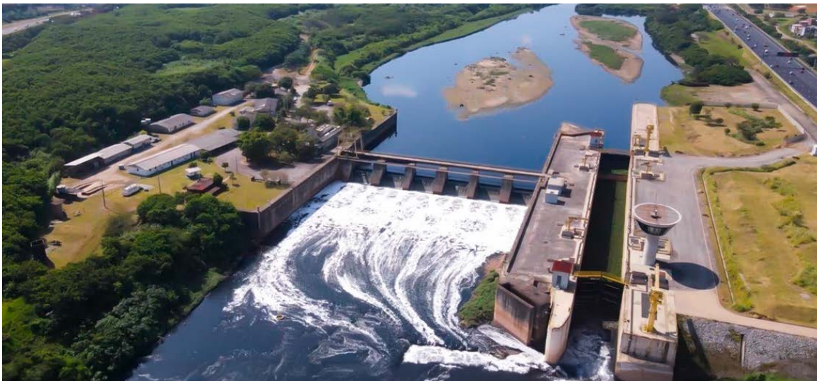
Fotografia 7 – Eclusa da Barragem da Penha
