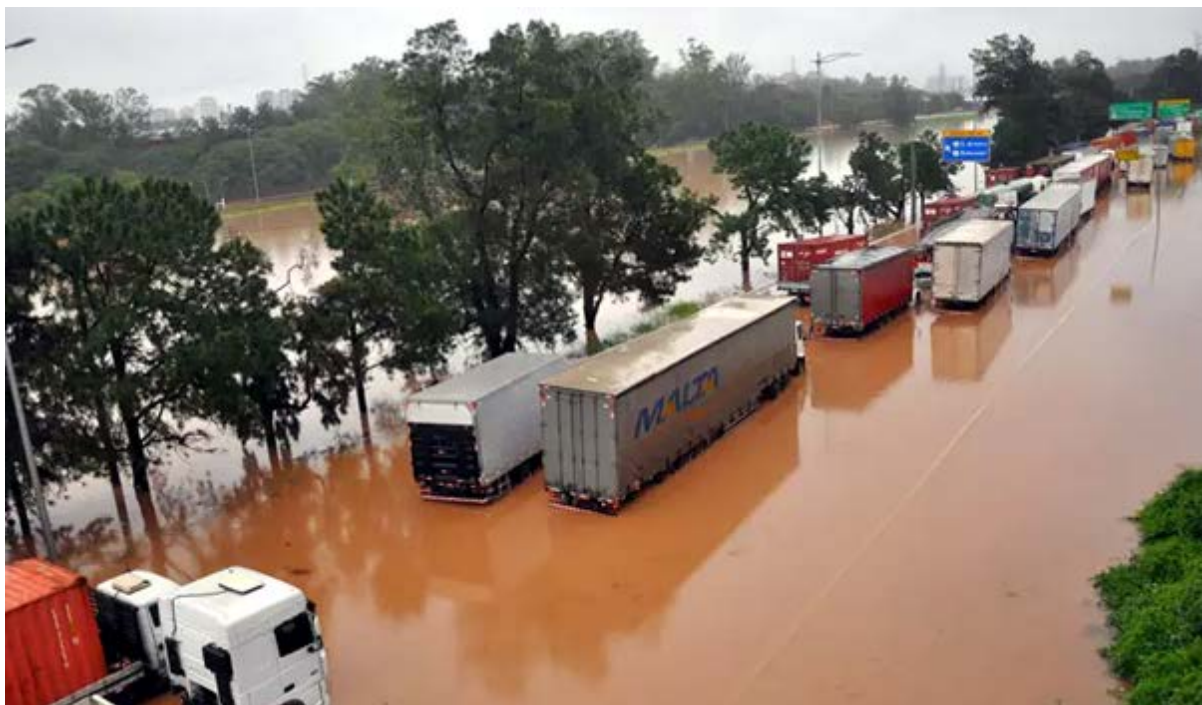
Fotografia 1 – Leito maior do rio Pinheiros ocupado por via expressa de longa distância.
