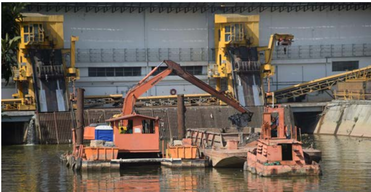
Fotografia 5 – Operação de dragagem a jusante da Usina de Traição
